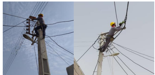
شکل ۱. نحوه قرارگیری سیمبانی در بالای تیر برق
