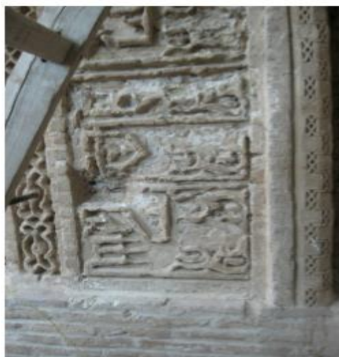
شکل ۲: آجرکاری رواق مسجد (۱۵)
